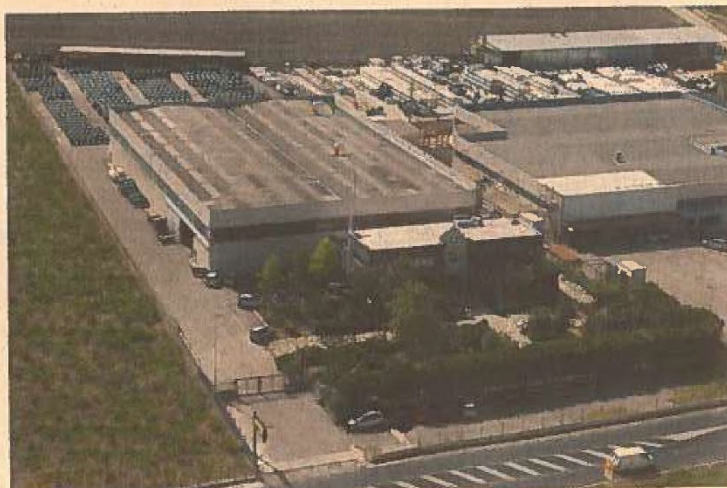
Lo stabilimento Sinco Srl
